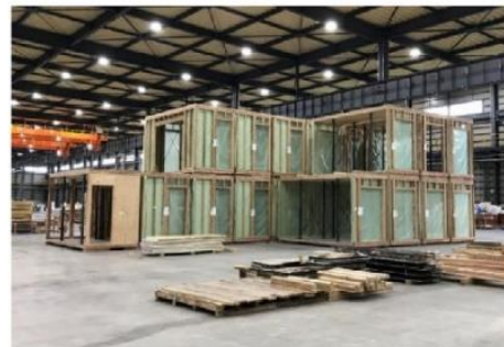
▲工場内で組み立てられた MOKUWELL HOUSE ユニット
