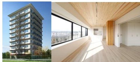
CLTを用いた10階建て共同住宅
