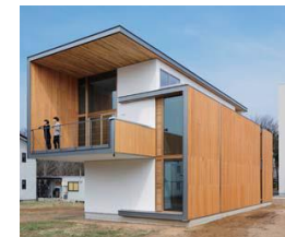
CLT工法による実験棟
