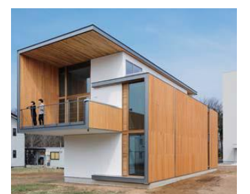
CLT工法による実験棟
