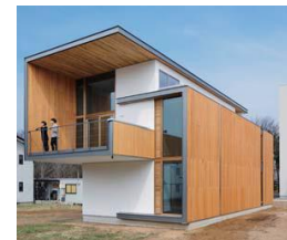
CLT工法による実験棟
