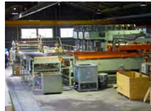
CLT量産製造工場 (岡山県 真庭市)
