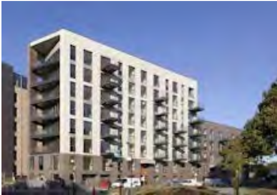
イギリスの8階建て共同住宅
