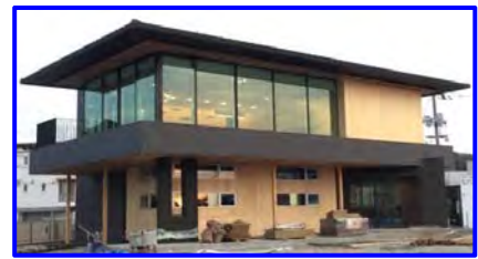
エス・バイ・エル・カバヤ(株) 事務所兼展示場 (H28.3竣工) 岡山県倉敷市 2階建て・1棟
