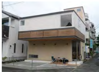
木造軸組工法(CLTを床版として使用) (神奈川県 藤沢市)
