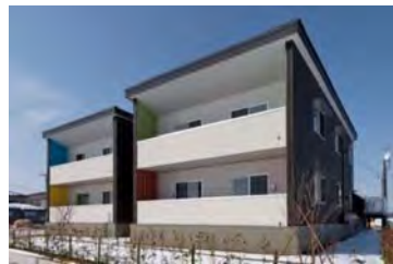
CLTパネル工法(福島県 湯川村)
