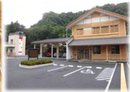
埼玉県皆野町：秩父消防署北分署
