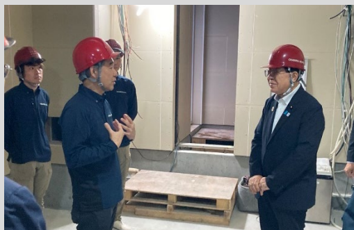
住宅建築の現場
