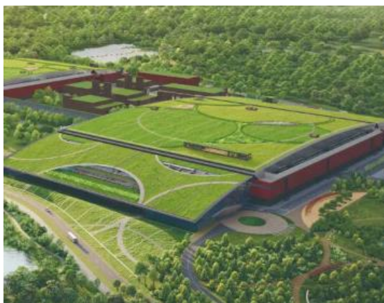
<次世代半導体工場>
