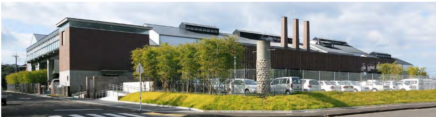
トータルエンジニアリング施工例 (焼酎工場外観)
