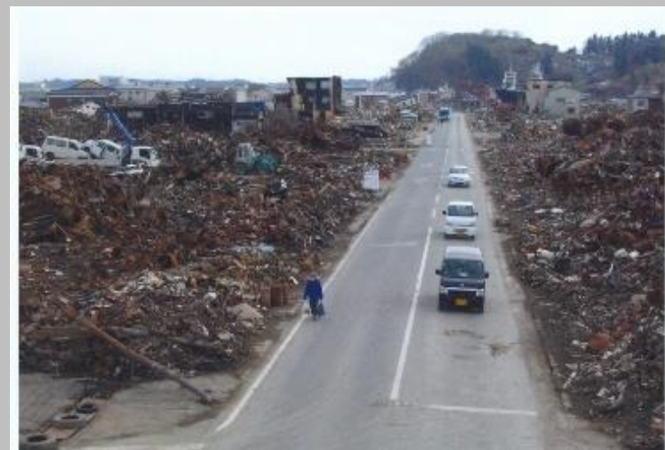
瓦礫の状況 ※5月28日撮影
