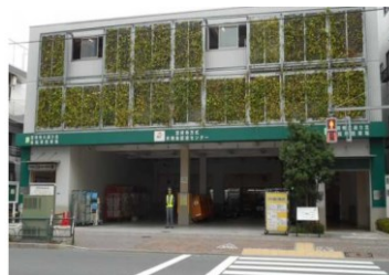
共同荷捌き施設
