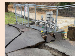
水道の復旧 (被災した浄水場)
