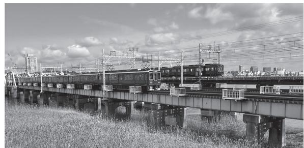
淀川に架かる阪急電鉄の鉄橋群。手前の神戸線と宝塚線の鉄橋より京都線の新しい鉄橋は高い。この状態のまま放置されており、治水安全度はさらに悪化している（筆者撮影）
