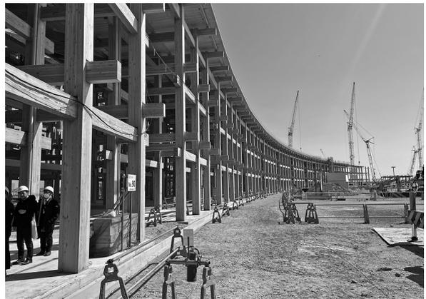
万博会場のシンボルとなる世界最大級の木造建築物、大屋根リング。延長約2km、高さ12mから20mの展望台を兼ねている（建設中の2023年3月、筆者撮影）
