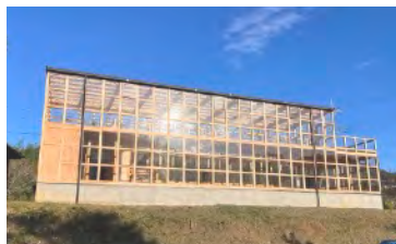
建設中の「琉庵」 茨城県常陸太田市
