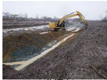
河道掘削 (石狩川水系、北海道開発局)
