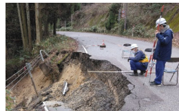
危険箇所での被災状況調査
