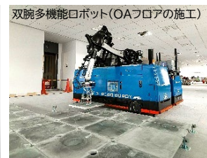
双腕多機能ロボット(OAフロアの施工)
