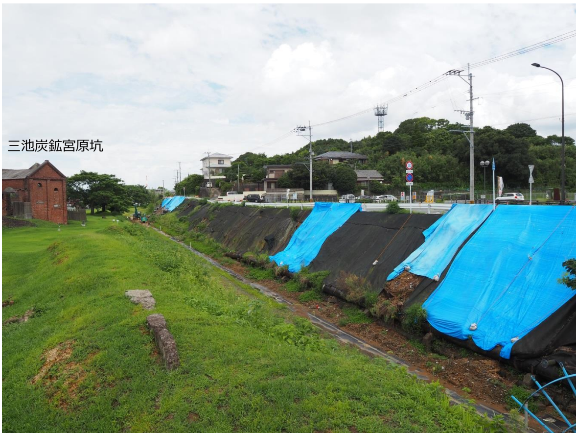
三池炭鉱専用鉄道敷跡 応急措置状況写真
