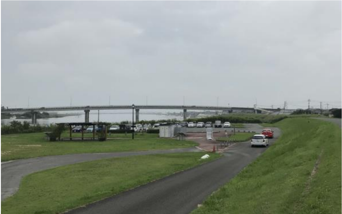
図 6 駐車場の現状（資産の西側道路から撮影）【2019. 8. 31 撮影】
