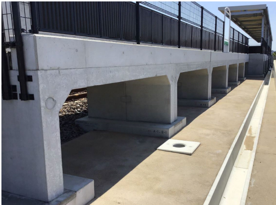
図 6 門型カルバート構造によるプラットフォームの構築例（構造案）
