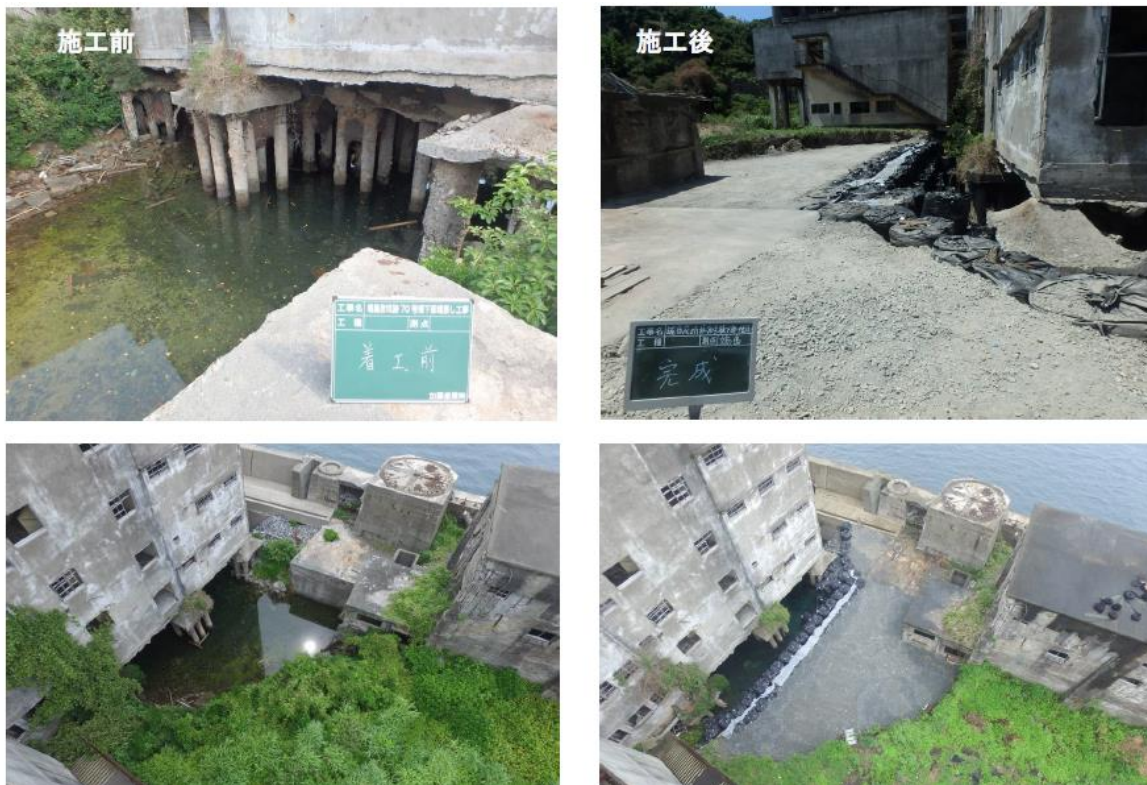
図-4 1991 年に被災した箇所の応急工事の前後の写真
