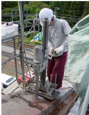
鉄筋挿入穴穿孔 (42φ, 3.8~7.0m)
