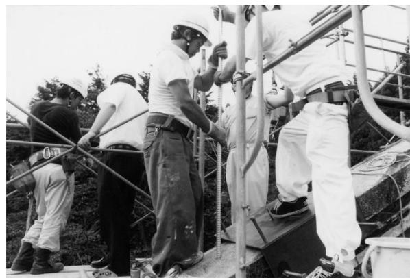
鉄筋挿入 (煉瓦厚 333mm, 1-D22)
