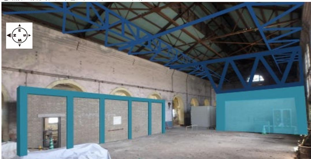
注)補強箇所の着色は、図中で施工範囲をわかりやすくしたもの。最終的に使用する色彩設計は、補強工事の視覚的影響が最小限となる色彩を採用する。
