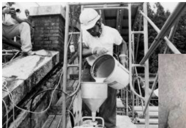
Pour cement slurry
