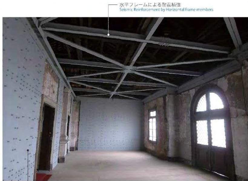
水平フレームによる耐震補強
