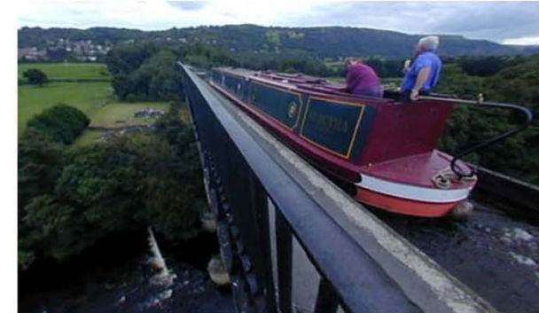
国：イギリス 遺産名：Pontcysyllte水路橋と運河 所有者：英国水路公社等 ステータス：稼働中 世界遺産の価値：産業革命の輸送を支えた運河土木技術 保護立法：運河法、史跡地区法 計画 (指定建造物及び保護地域) 法等
