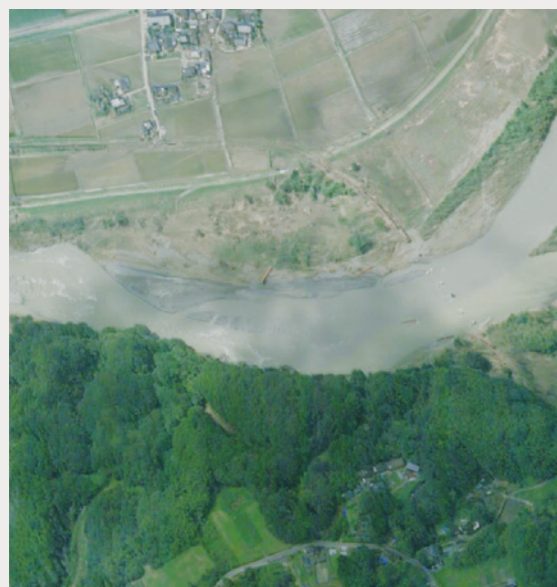
熊本県(令和2年7月熊本県豪雨橋梁消失)
