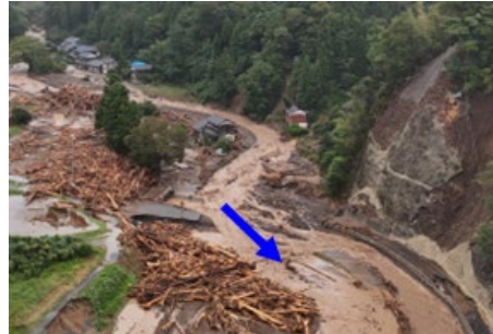
塚田川における人家流失・ 流木阻害(石川県輪島市)
