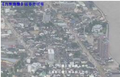
球磨川における浸水被害状況 (熊本県人吉市)
