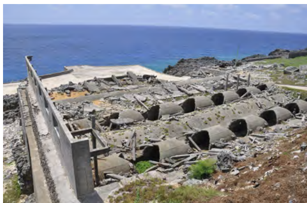
北大東島燐鉱山遺跡 復原された貯蔵庫遺構 提供:北大東村教育委員会
