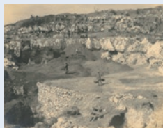
北大東島におけるリン鉱石の採掘風景 出典：『北大東村誌』
