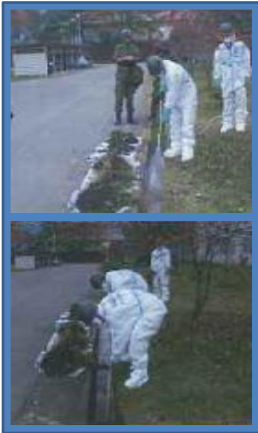
側溝の汚泥除去
