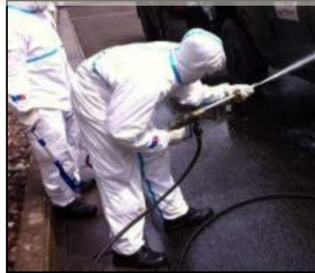
庁舎玄関部等の除染 建屋雨どい等の汚泥除去 駐車場等の高圧洗浄
