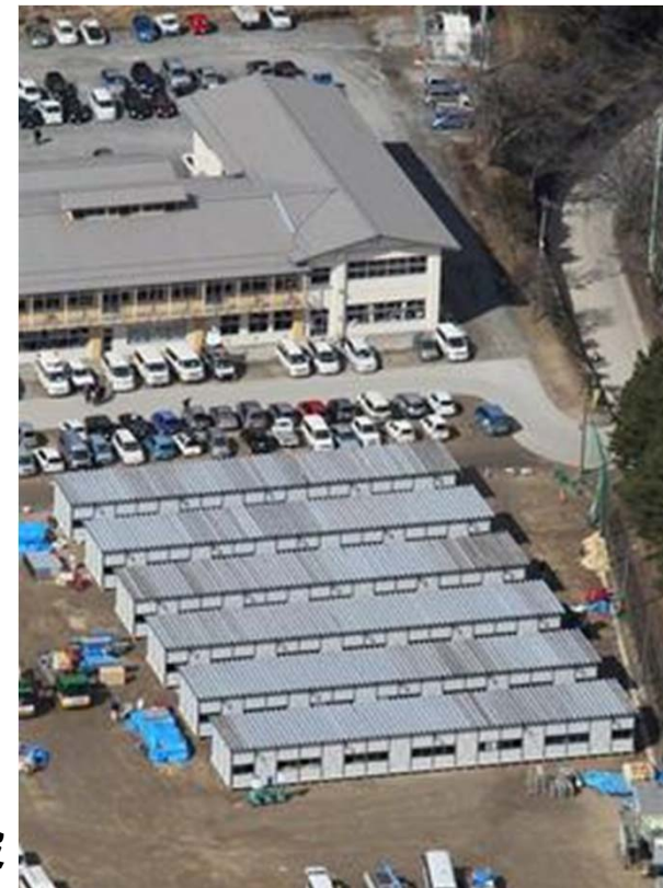
仮設住宅の建設
