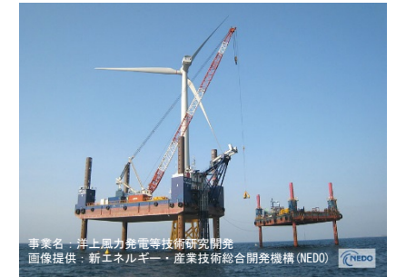
洋上風力発電施設の施工例
