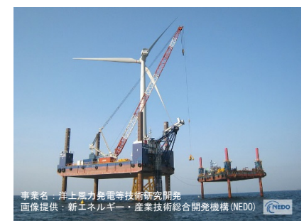
洋上風力発電施設の施工例
