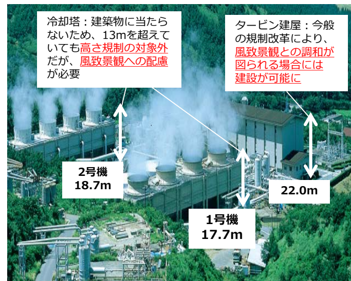
八丁原地熱発電所（大分県） ※タービン建屋が13mを超えている事例
