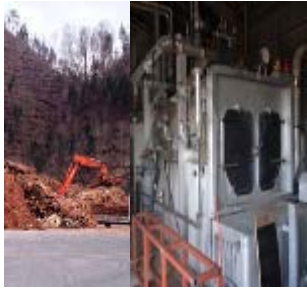
＜バイオマス発電所＞
