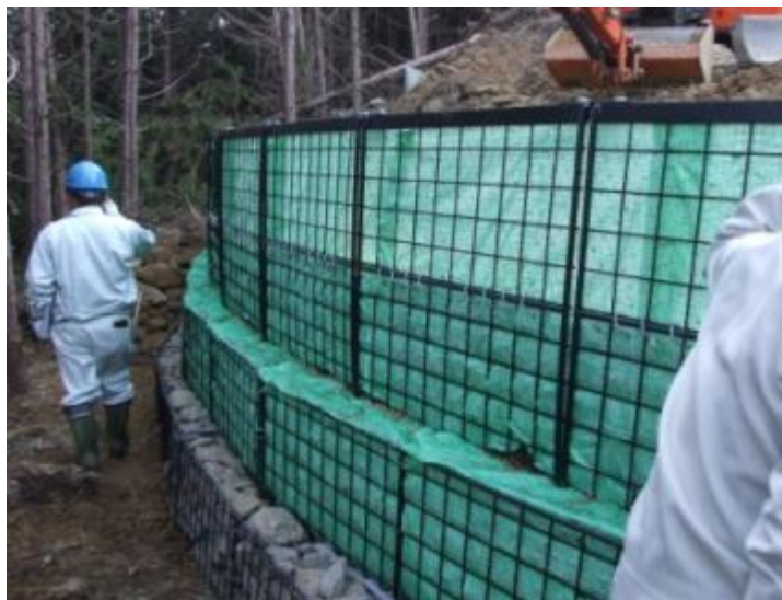
鋼製土留工の施工事例(京都府)
