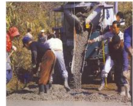
容易な施工(人力施工)
