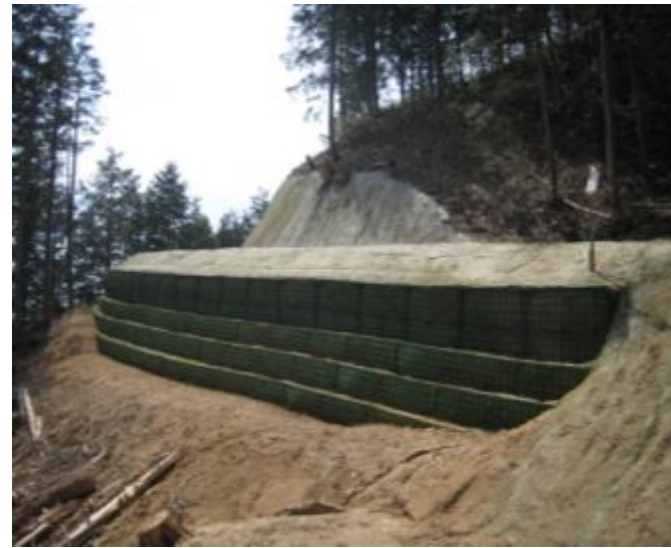
鋼製土留工の施工事例(京都府)
