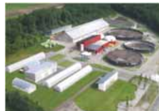
バイオガス発電・熱利用
