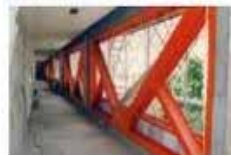
鉄骨ブレースによる壁の補強
