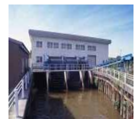
排水機場の整備
