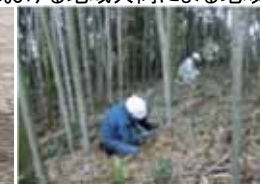
侵入竹の伐採・除去
