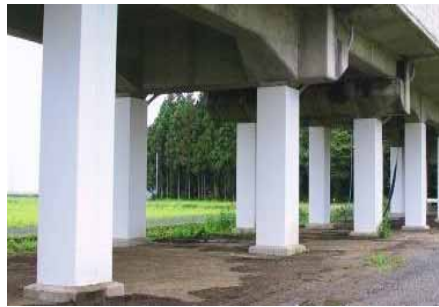
鋼板巻きによる高架橋の耐震対策
