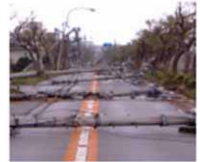
電柱の倒壊による道路閉塞
