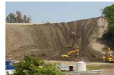
盛土撤去工事のイメージ
