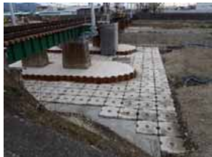
鉄道橋梁の流失・傾斜対策
