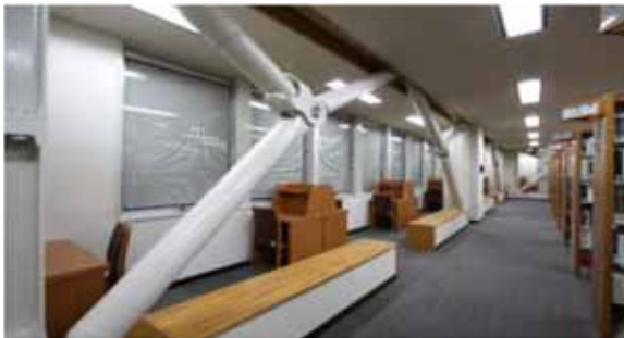
補強材(筋かい)の設置
