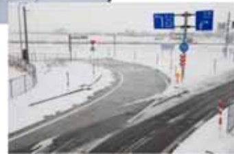
消融雪施設の整備
