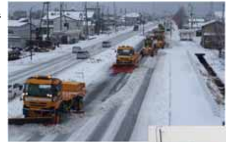
除雪機械の整備
