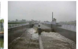
(排水分水ゲート)
