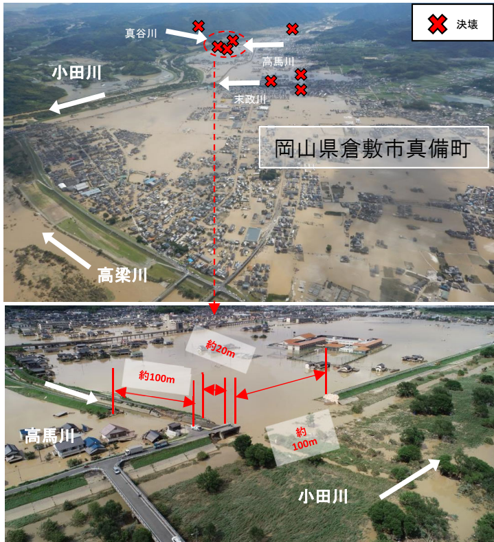
平成30年7月豪雨における浸水被害
