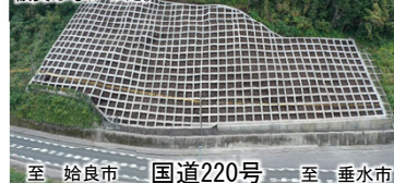
3か年緊急対策 整備事例 国道220号(鹿児島県) <令和2年12月完了>
