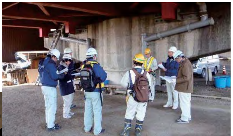
岐阜県橋梁点検マニュアル による試し点検
