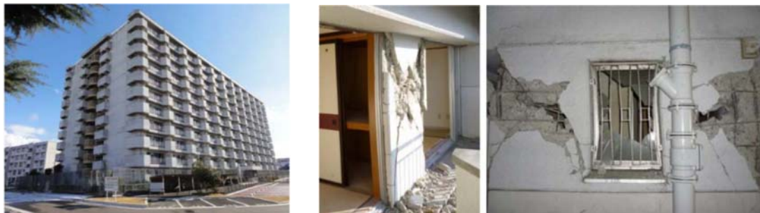
東日本大震災 建築基準法を満たし人命は守ったが、損傷が多く取り壊された集合住宅
