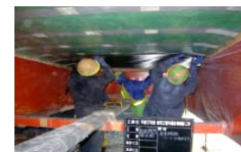
炭素繊維シートによる補修
