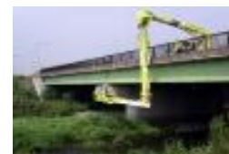
橋梁点検車を使った橋梁点検
