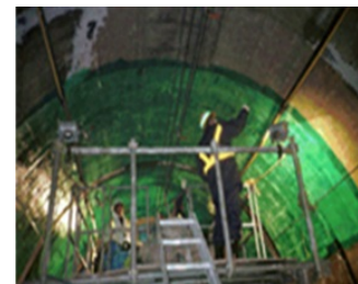
【繊維シート貼り付けによる老朽化対策】
