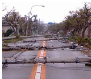
電柱の倒壊による道路閉塞
