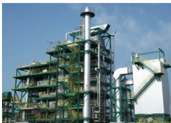
木質バイオマス発電所
