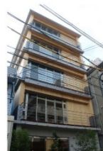
CLTを用いた建築例(奈良県)
