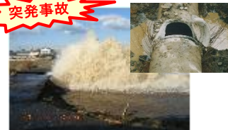
パイプラインの破裂による 用水供給機能の停止
