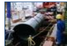
基幹管路の耐震化
