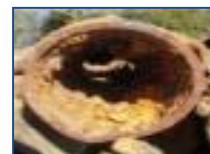
管路の老朽化が進行
