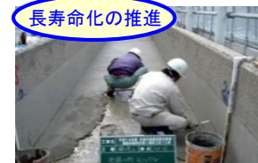
開水路の補修
