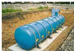
耐震性貯水槽
