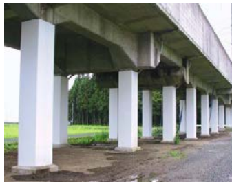
【鋼板巻きによる耐震対策】
