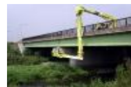
橋梁点検車を使った橋梁点検
