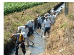
水路の泥上げ
