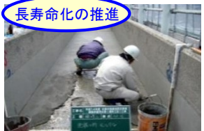
開水路の補修
