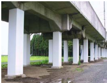
【鋼板巻きによる耐震対策】
