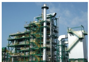
木質バイオマス発電所
