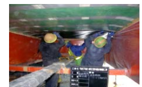
炭素繊維シートによる補修
