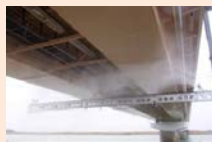
塩分の飛来・付着特性と塗装の劣化を考慮した鋼桁洗浄システムの開発
