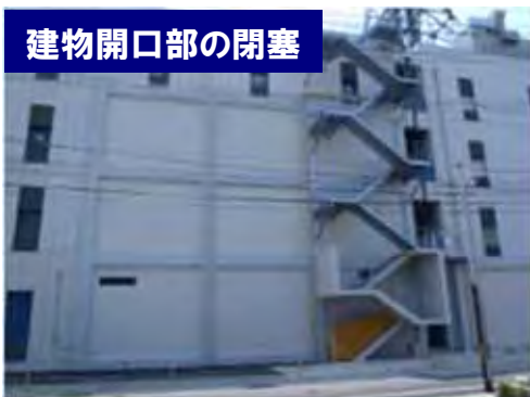
(例) 宮城県 石巻門脇ビル
