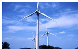
【風力発電設備】
