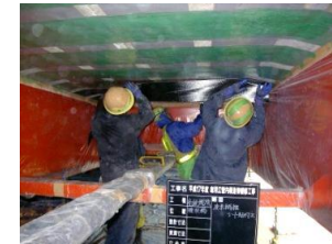
炭素繊維シートによる補修
