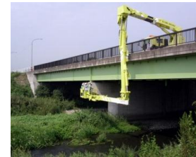
橋梁点検車を使った橋梁点検
