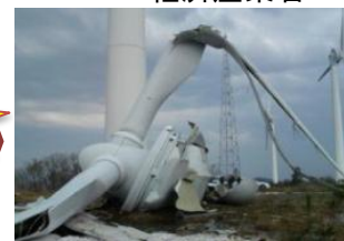
【風車落下事故の状況】
