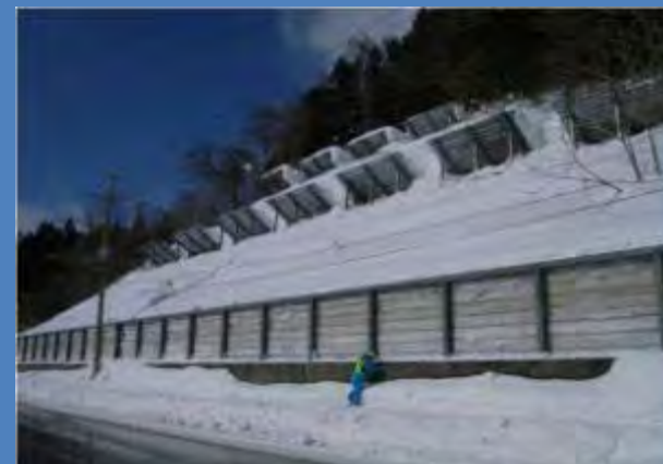
雪崩防止柵の設置
