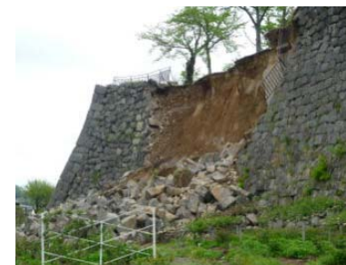
「史跡・小峰城跡」 (福島県白河市) 東日本大震災により被災
