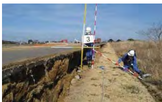
河川被災状況の調査
