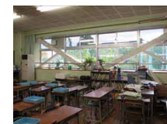
ブレース補強
