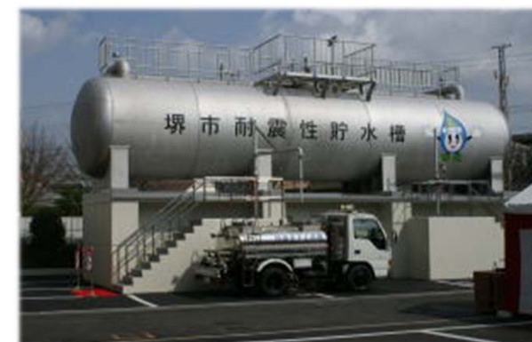
飲料水兼用耐震性貯水槽(堺市HPより)
