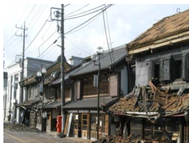
「香取市佐原 伝統的建造物群保存地区」 (千葉県香取市) 東日本大震災により被災
