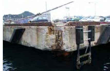
老朽化した岸壁の状況
