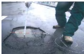
背後道路の陥没
