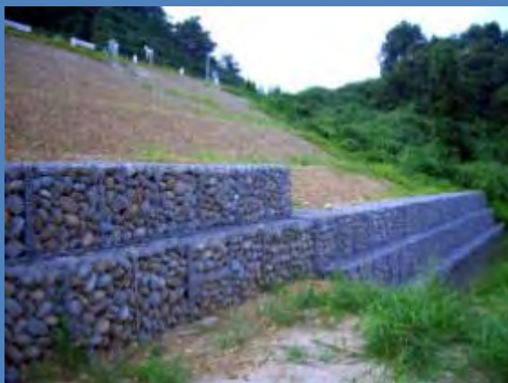
ふとんかごの設置による盛土のり尻部の補強
