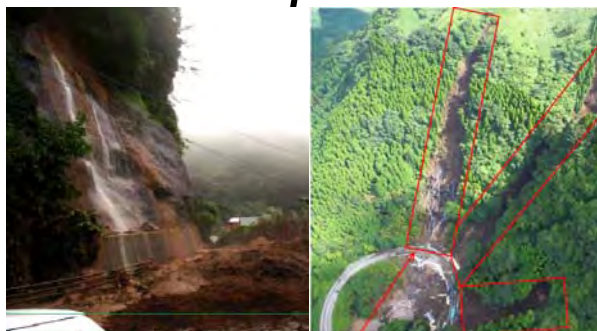
一般国道57号 法面崩落状況
