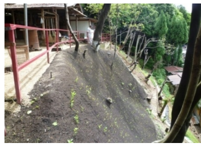
「史跡・賀茂御祖神社境内」 (京都府京都市) 地盤の崩落防止措置
