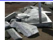
落下したコンクリート
