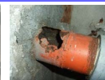
劣化による配管破損
