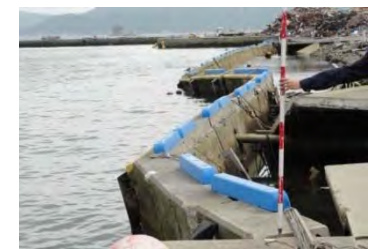
老朽化による強度不足から岸壁が滑動する場合があります
