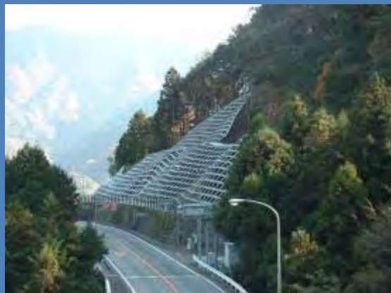
法枠工・アンカー工による斜面崩落防止
