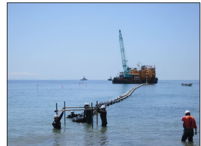
海底ケーブル布設(陸揚げ)状況 (平成24年6月)
