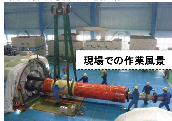
海南2号機 発電機回転子巻線の搬出
