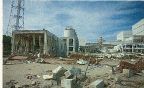
震災後の原町火力発電所
