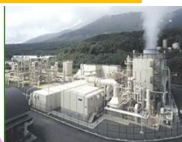
地熱発電施設
