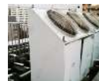
電機ヒートポンプ
