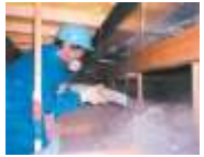
天井の断熱改修
